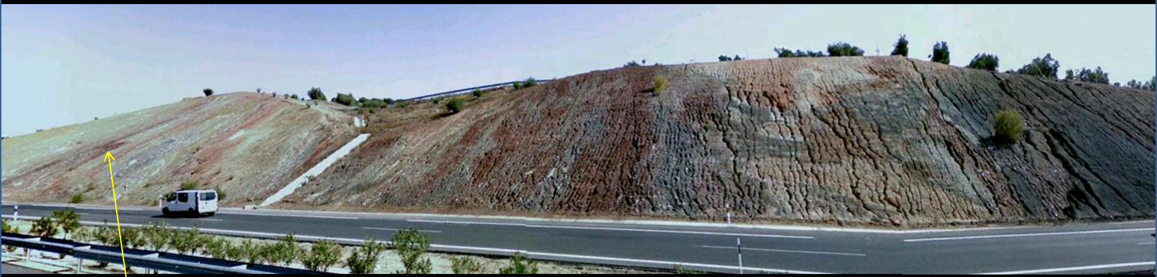
Taludes en las arcillas, margas y yesos del Triásico de la A-45. NW Hoja de Rute, Córdoba. N de Encinas Reales. Detalle.
